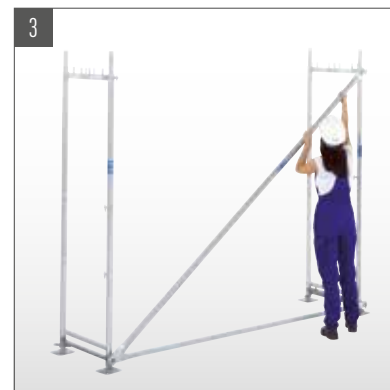
3 Diagonale über Kippstifte montieren.
