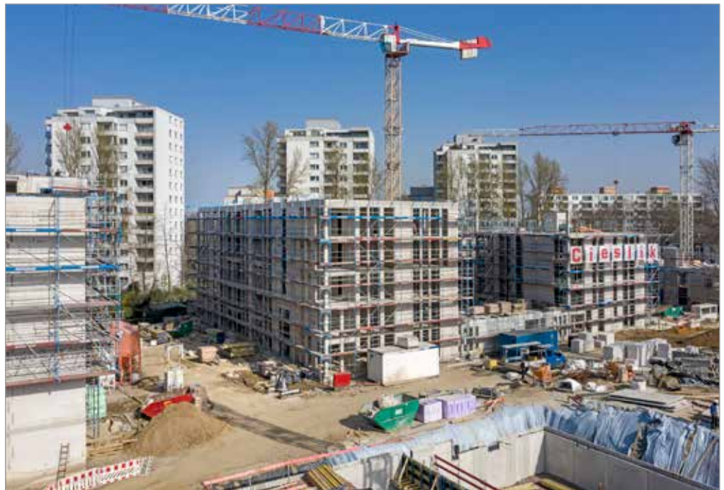
Neubau einer Wohnanlage mit 306 Wohneinheiten mit Tiefgarage in Essen
