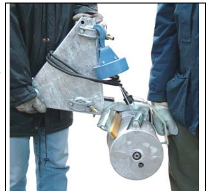
Fig. 8 Winde ans Gerüst heben
